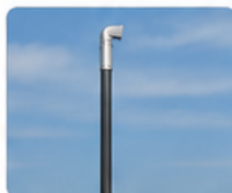
TUYAUTERIE D'ÉVENT Hauteur 4 m
