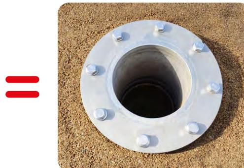
Comblers le pourtour de la bride, compacter la couche de sable. Le plat inox doit se situer au niveau du sable. Laisser les vis dans les écrous pour éviter l'insertion de sable.
