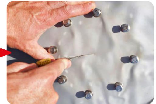
Positionner toutes les vis, découper soigneusement le liner en suivant la forme du tube intérieur.
