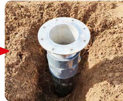
Visser le manchon sur la traversée inox DN100-M4" avec du téflon, coller le manchon 110x4" sur le tuyau. Vérifier la hauteur finie avant de coller. L'étape suivante montre le résultat à obtenir.
