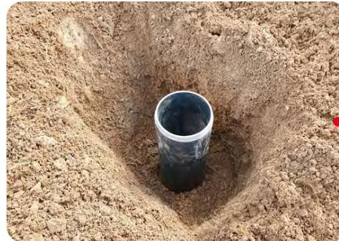
Ajuster la hauteur du tuyau PVC-P en tenant compte de la hauteur du manchon et du bloc bride inox..
