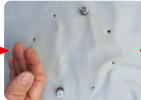
Pré-percer un deuxième trou à l'opposé du premier, placer une vis. Pré-percer les autres trous.
