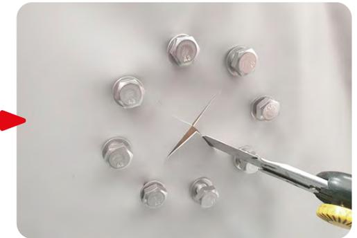
Découper soigneusement le liner en suivant la forme du tube intérieur.
