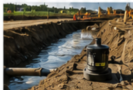
DRAINAGE DE CHANTIER ET FOUILLES
